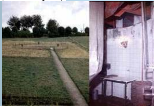
Большой гидравлический испаритель (внешний вид и подземная камера)
