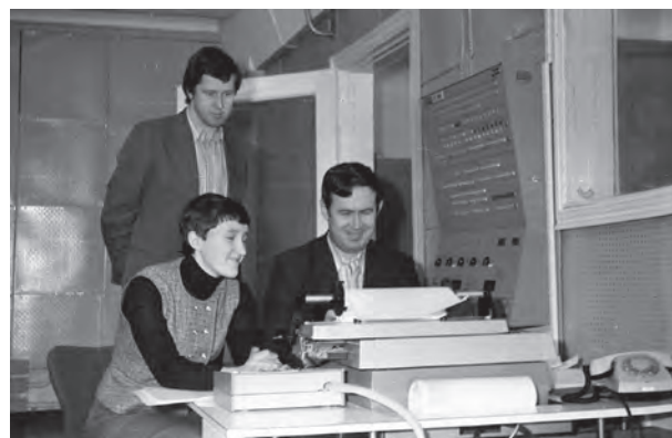
Системные программисты проверяют работу ОС на ЕС ЭВМ
